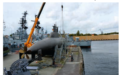
U 10 – Verlegung des Treppenaufganges
