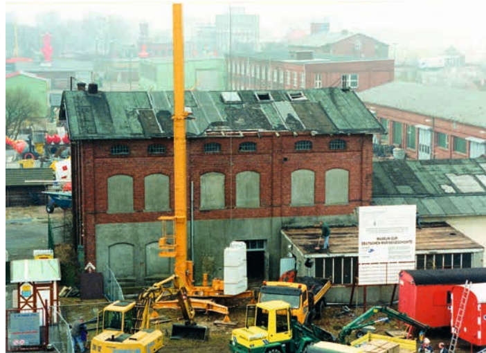
Baustelle Deutsches Marinemuseum
